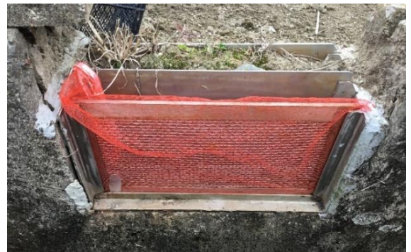
図3：被覆肥料のコーティング流出防止対策の例
