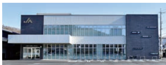
完成した井原支店
