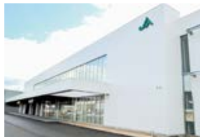
2階に多目的兼会議室も備えた倉敷東支店
